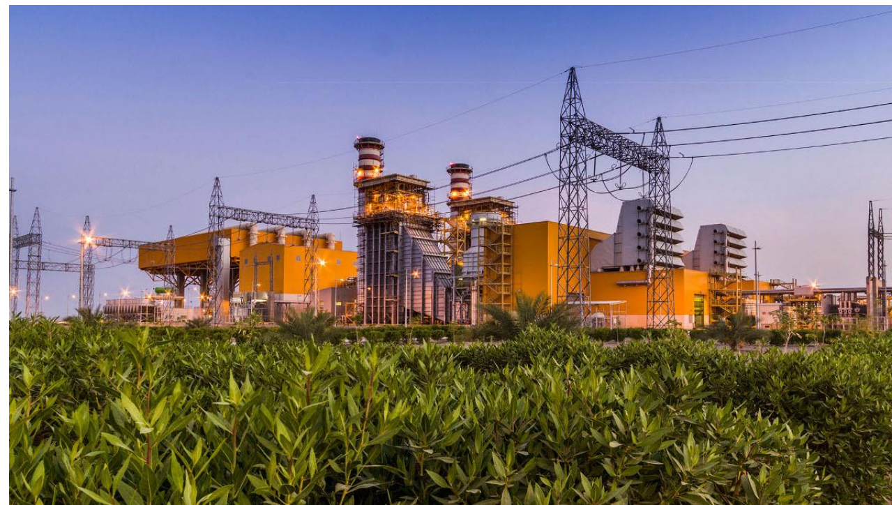
نیروگاه سیکل ترکیبی شوباد
