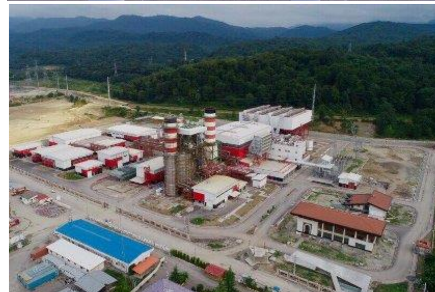
نیروگاه سیکل ترکیبی کاسپین
