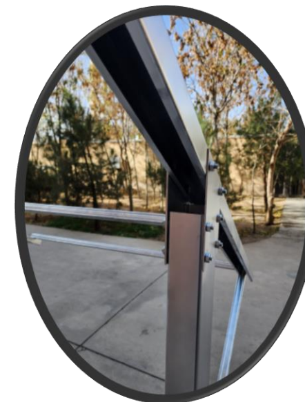
اتصالات کاملاً پیچ و مهره ای جهت سهولت مونتاژ و دمونتاژ سازه
