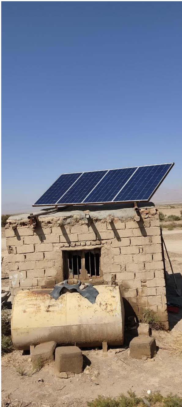
نمونه ای از اجرای نیروگاه های آفگرید و پمپ های سولار
